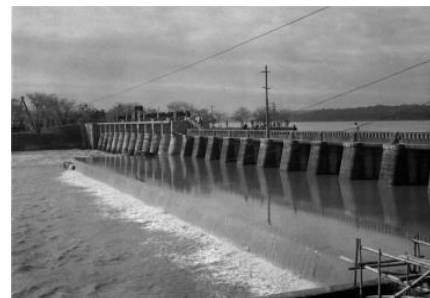
洗堰嵩上げ工事
