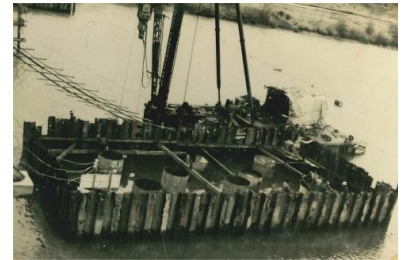
建設中の渡部橋橋脚
