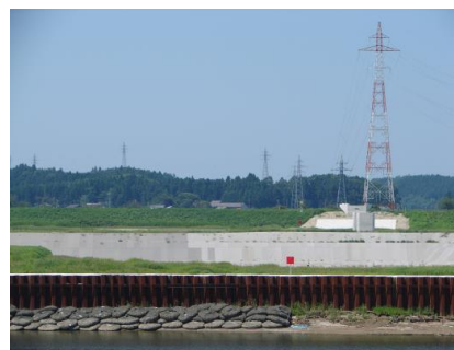
右岸堰軸から近景を撮影 （平成19年8月14日撮影）
