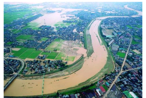
五十嵐川破堤状況
