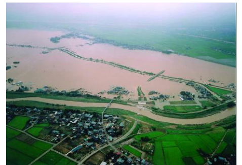
刈谷田川破堤による浸水状況
