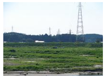
右岸堰軸から近景を撮影 (平成18年8月24日撮影)
