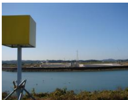
右岸堰軸から撮影 (平成20年11月13日撮影)
