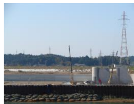
右岸堰軸から近景を撮影 (平成20年11月13日撮影)
