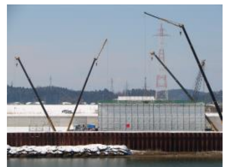
右岸堰軸から近景を撮影 (平成22年2月18日撮影)
