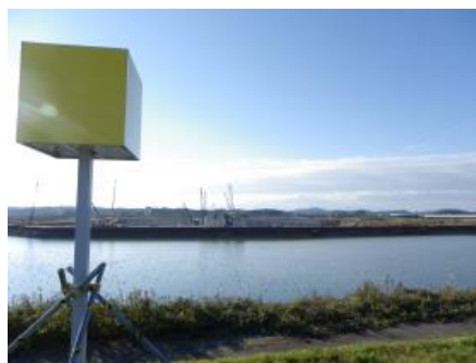
右岸堰軸から撮影 (平成 22 年 11 月 27 日撮影)
