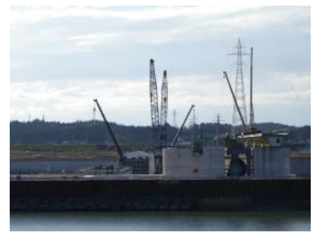
右岸堰軸から近景を撮影 (平成 22 年 11 月 27 日撮影)
