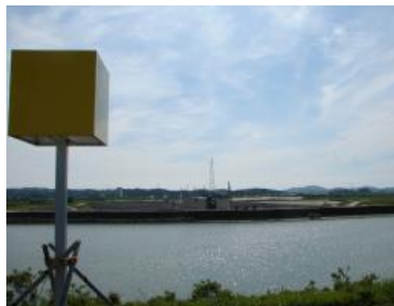
右岸堰軸から撮影 (平成22年6月6日撮影)
