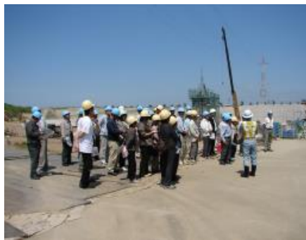
可動堰改築工事現場の様子 （平成22年6月4日撮影）
