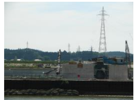
右岸堰軸から近景を撮影 (平成22年6月6日撮影)
