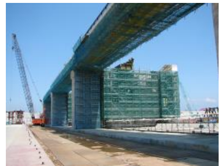
堰柱と管理橋 （平成22年6月4日撮影）
