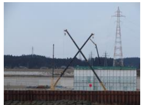
右岸堰軸から近景を撮影 (平成21年2月6日撮影)
