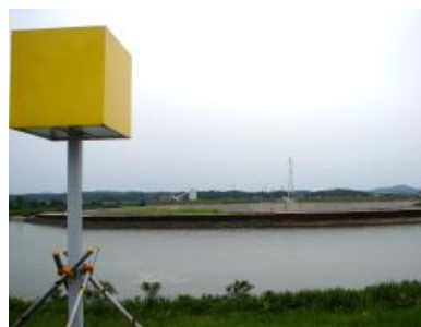
右岸堰軸から撮影 (平成19年6月14日撮影)
