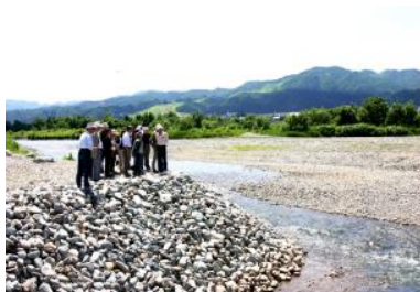
水尾新田護岸災害復旧工事
