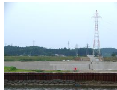
右岸堰軸から近景を撮影 (平成19年6月14日撮影)
