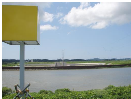
右岸堰軸から撮影 (平成21年8月14日撮影)
