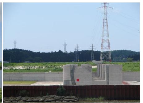
右岸堰軸から近景を撮影 (平成21年8月14日撮影)
