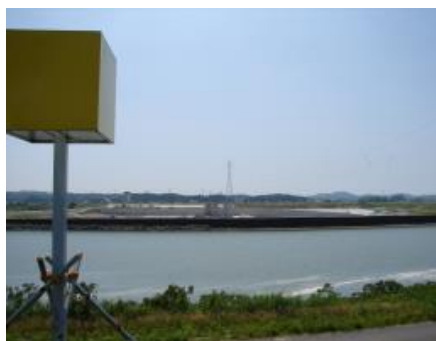
右岸堰軸から撮影 (平成20年6月12日撮影)
