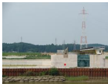
右岸堰軸から近景を撮影 (平成22年8月8日撮影)
