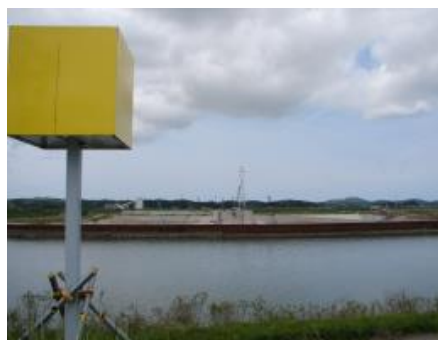
右岸堰軸から撮影 (平成21年5月15日撮影)
