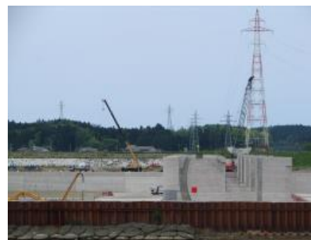
右岸堰軸から近景を撮影 (平成21年5月15日撮影)
