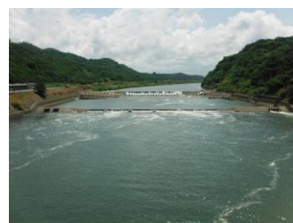
事業着手となった 分水路河口
