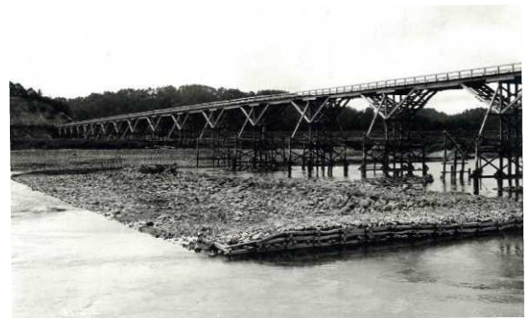
木橋の渡部橋(昭和 3 年撮影)
