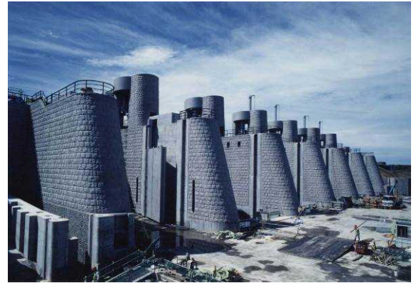
完成間近の新洗堰
