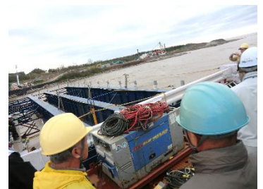
河口部右岸 野積橋橋脚 工事現場
