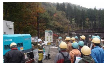
↑大源太川第1号 砂防堰堤工事現場 で概要説明
