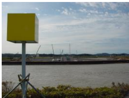
右岸堰軸から撮影 (平成21年11月13日撮影)
