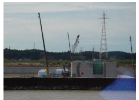
右岸堰軸から近景を撮影 (平成21年11月13日撮影)
