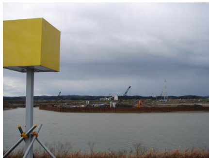
右岸堰軸から撮影 (平成18年12月5日撮影)
