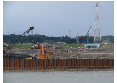
右岸堰軸から近景を撮影 (平成18年12月5日撮影)
