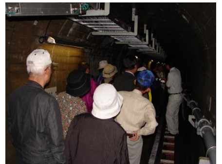
大谷ダム監査廊
