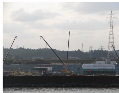
右岸堰軸から近景を撮影 (平成19年12月21日撮影)
