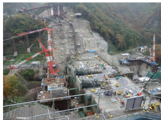
建設が進むハッ場ダム工事現場
