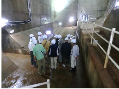
内の倉ダム内部
