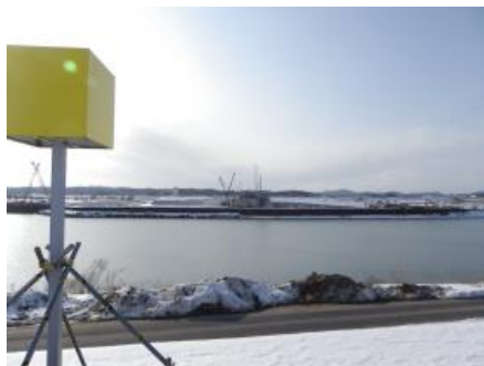
右岸堰軸から撮影 (平成23年2月8日撮影)
