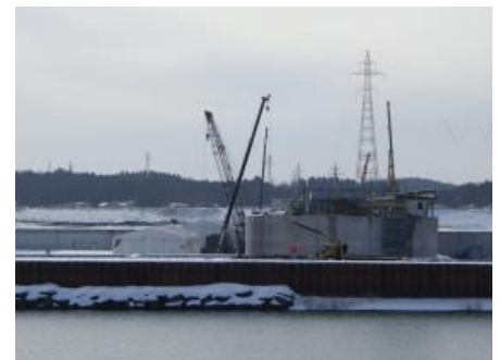
右岸堰軸から近景を撮影 (平成23年2月8日撮影)
