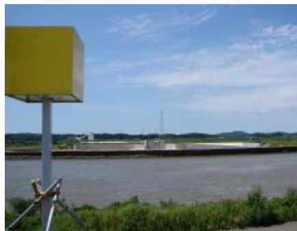
右岸堰軸から撮影 (平成20年8月31日撮影)
