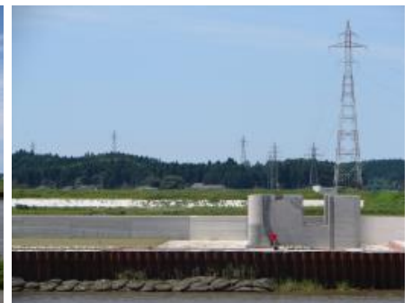
右岸堰軸から近景を撮影 (平成20年8月31日撮影)
