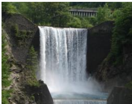
釜が淵砂防堰堤
