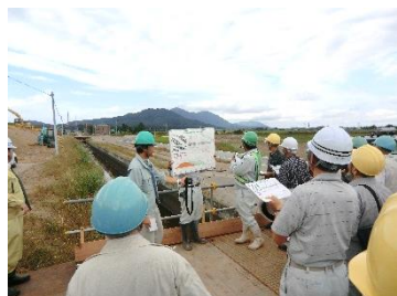
蒲原用水路工事現場
