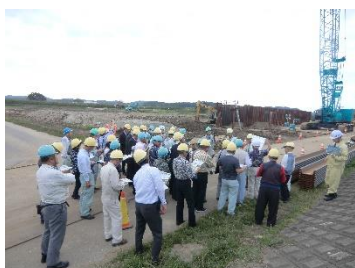
島崎川樋管・排水機場 改築工事現場
