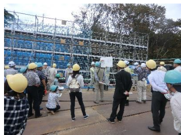
新野積橋橋台工事現場
