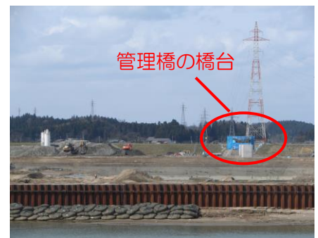
右岸堰軸から近景を撮影 (平成19年3月15日撮影)
