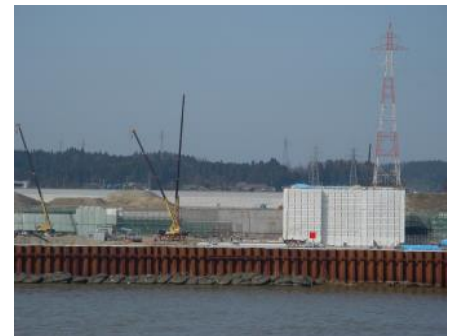
右岸堰軸から近景を撮影 (平成20年3月22日撮影)
