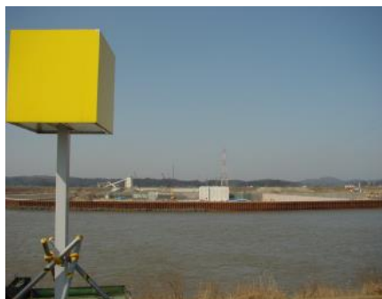
右岸堰軸から撮影 (平成20年3月22日撮影)
