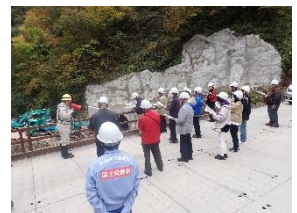
← 利賀ダム転流工 トンネル工事現場
