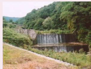
万内川砂防堰堤 (画像:新潟県HPより)
